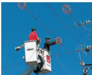
Em algumas zonas, a EDP Distribuição procedeu à colocação de "espirais de sinalização" nas suas linhas de distribuição de energia eléctrica, para diminuir o risco de colisão por parte das aves. A instalação destes dispositivos de sinalização, aumenta o grau de visibilidade das linhas.
